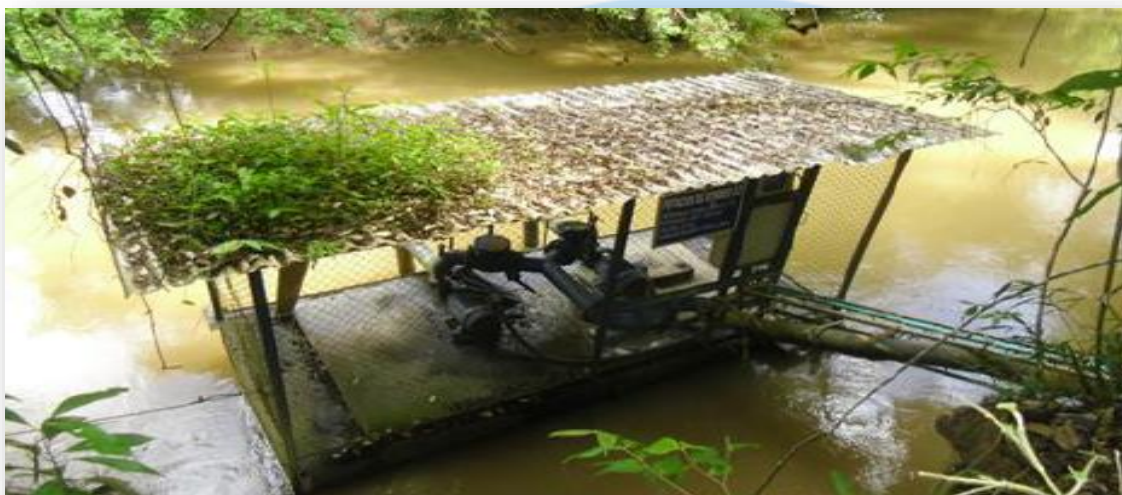
Imagen 3-3. Captación Caño Grande
